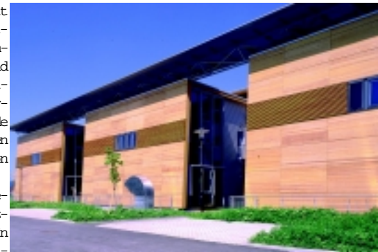
Bautechnikzentrum der TU Graz
